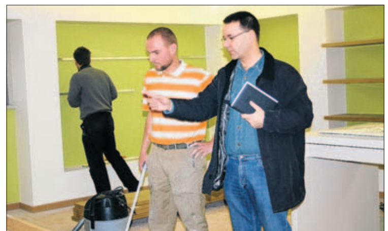
Der Leiter des Hoflades, Ulf Hrybinski (r.), stimmt mit Tischler Michael Köhn die Einbauarbeiten in der Einrichtung ab. Foto: C.M.
